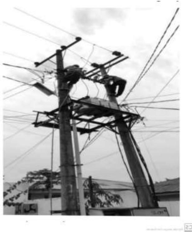
Gambar 4. Pemeliharaan *Lightning arrester*
