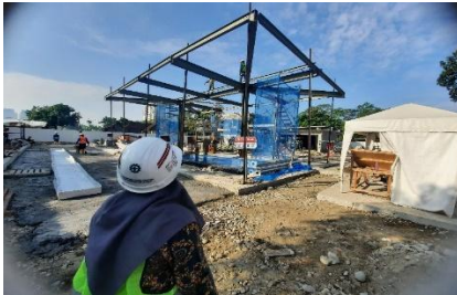
Gambar 4 : Pekerjaan pemasangan Canopy
