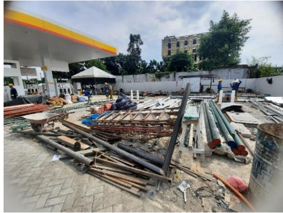
Gambar 7: Kondisi Perletakan Material
