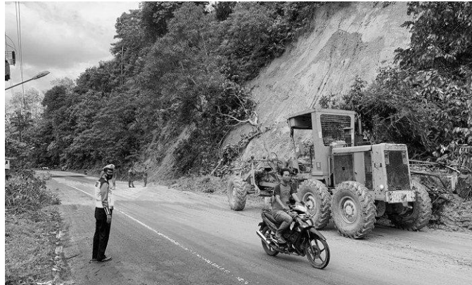
Gambar 15: Kejadian Tanah Longsor ( 26 september 2020 ) di Desa Seumadan, Kecamatan Kejuruan Muda, Kabupaten Aceh Tamiang
