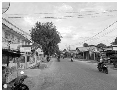
Gambar 4 : Kondisi Rambu Segmen 1
