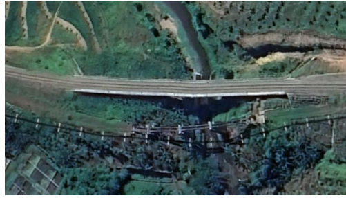
Gambar 1: Lokasi jembatan BH-40 (Google Earth).
