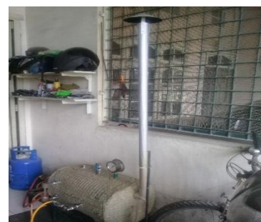
Gambar 8 Cerobong (Sumber: Dokumentasi pribadi, 2020)
