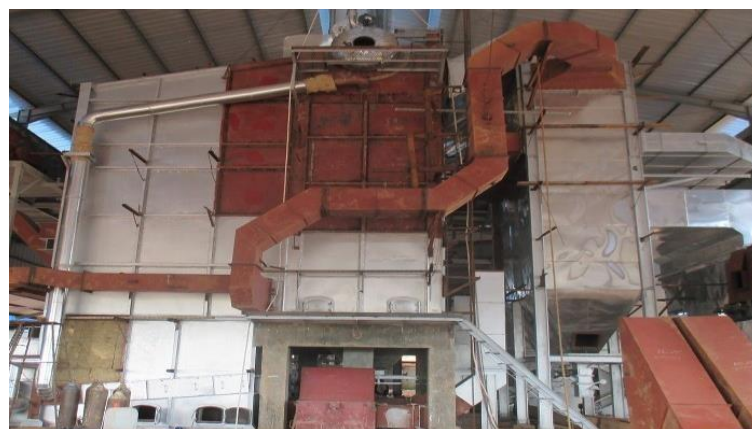
Gambar 2: Ketel Pipa air oleh PLTU PT. GIP Growth Asia
