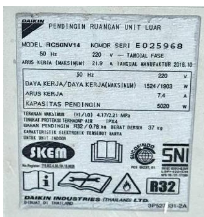
Gambar 14: Spesifikasi unit AC yang tertera pada nameplate unit
