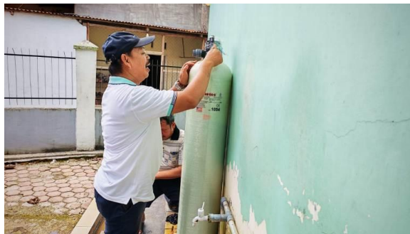
Gambar 5. Pemasangan filter air
