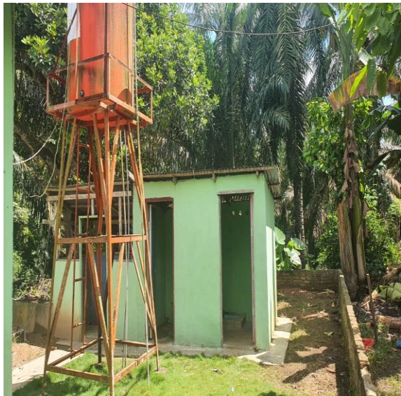
Gambar 4. Belum ada penerangan
