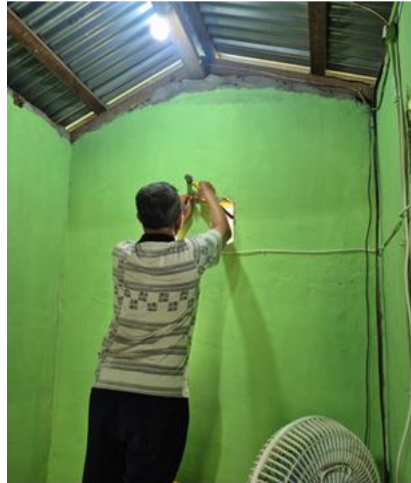
Gambar 6. Perbaikan instalasi listrik dalam mushola
