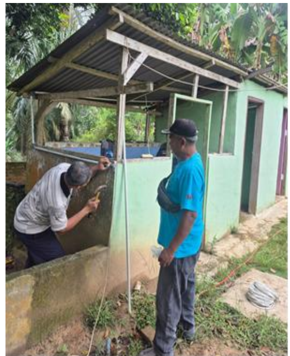
Gambar 7. Perbaikan instalasi pipa ke WC
