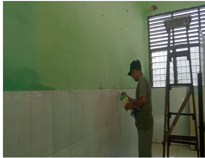
Gambar 7. Pembersihan area sebelum dilakukan pengecatan
