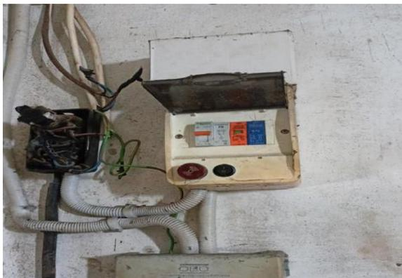
Gambar 8. Sistem proteksi internal di Jembatan Timbang 40 dan 50 ton
