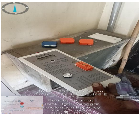
Gambar 4. Pengukuran tahanan isolasi surge arrester di Kantor Besar
