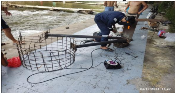
Gambar 3. Pembuatan kerangka Basin
