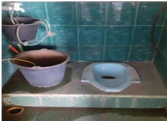
Gambar 3. WC yang menggunakan air sumur untuk penyiramannya
