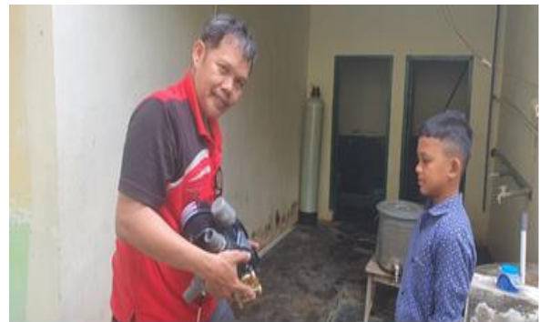
Gambar 7. Pemasangan instalasi filter
