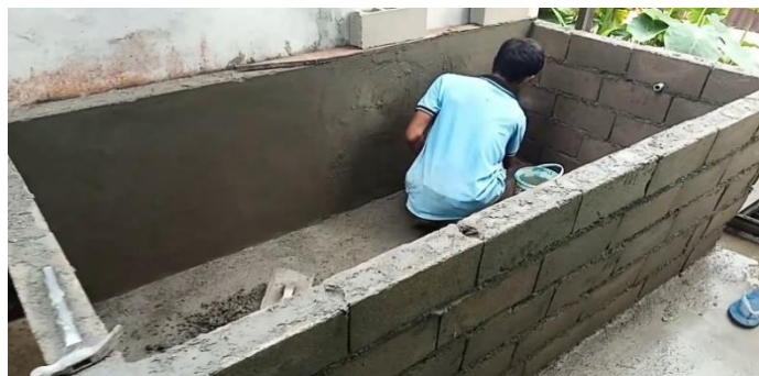
Gambar. 3. Konstruksi Kolam Beton
