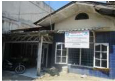
Gambar 1. Tampak depan bangunan
