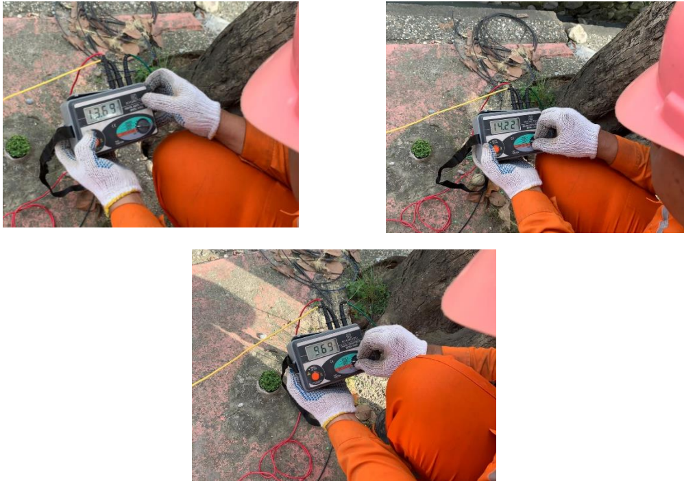
Gambar 7. Hasil Pengukuran Sebelum Perbaikan
