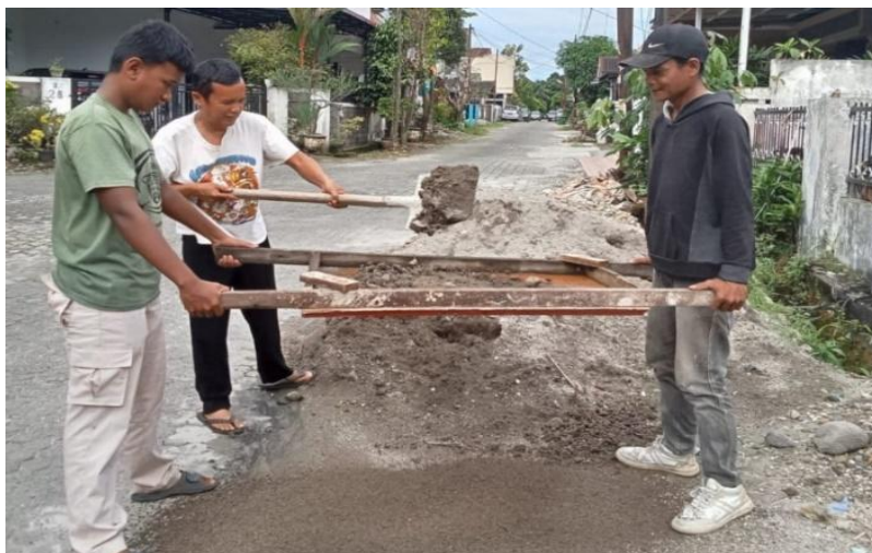
Gambar 1. Situasi mengayak pasir secara manual dengan 3 orang tenaga kerja.
