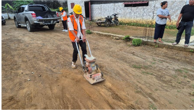
Gambar 3. Pemadatan dan Perataan Area Jalan
