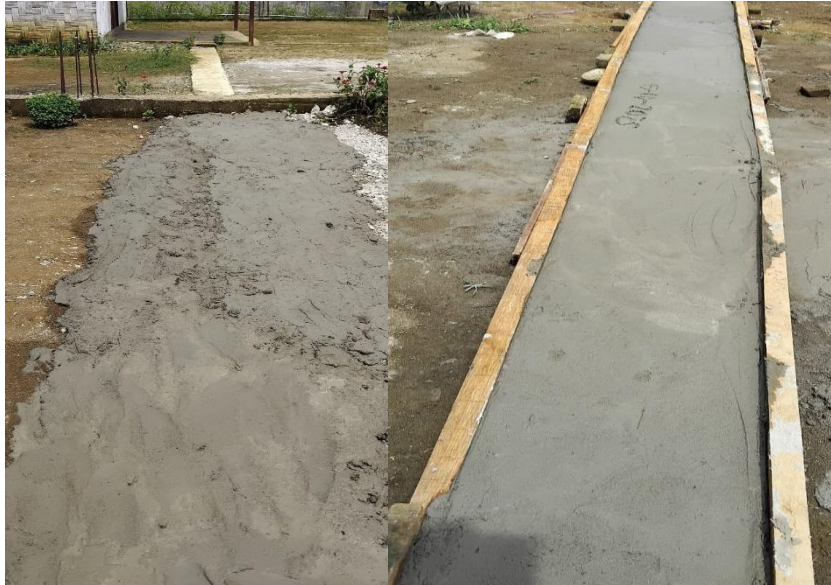
Gambar 6. Penghamparan Beton dan Finishing
