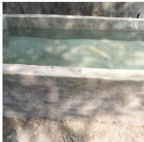
Gambar 2. Pengujian Ketahanan dan Kebocoran Kolam
