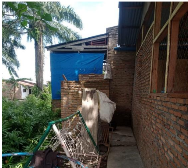
Gambar 3. Kondisi Eksisting Kamar Mandi TK Mutiara Bangsa
